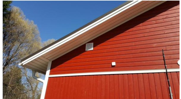
4. Ulkoverhoukset ovat hyväkuntoisia.
