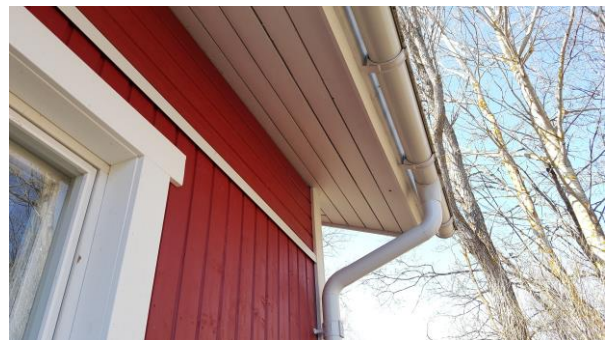
8. Sadevesivarusteet ovat hyväkuntoisia.
