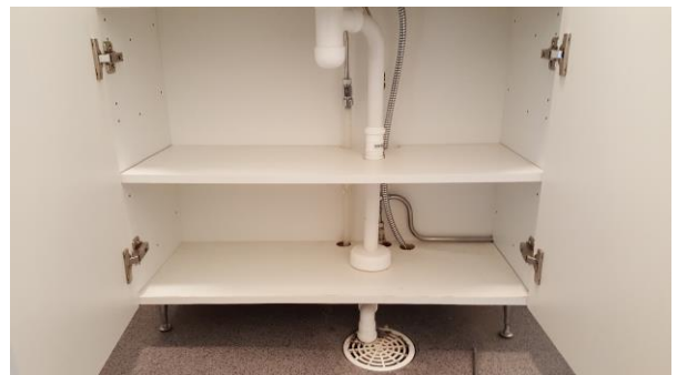
24. Kaikki näkyvillä olevat putkiasennukset olivat ehjiä ja vuotamattomia.
