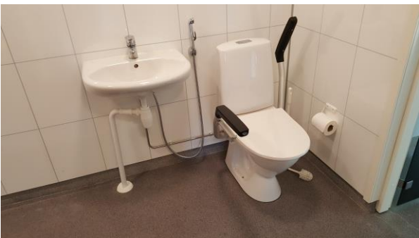
23. Pesuhuoneessa on lisäksi wc -istuin ja pesuallas sekä kodihoitopaikka. Lattiasa on vesieristävä pinnoite.
