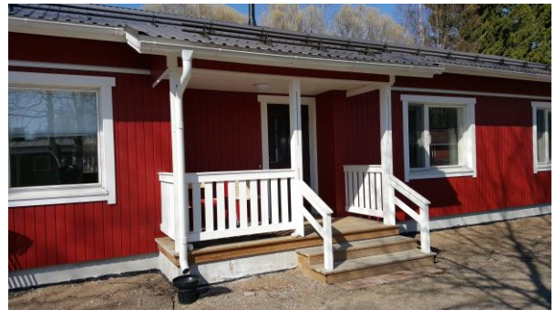
2. Rakennuksen kaikki kuistit, terassit ja ulkoportaat ovat hyväkuntoisia.
