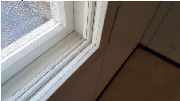
3. Ikkunat ovat hyväkuntoisia.
