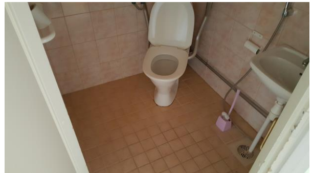
22. Rakennuksessa on 4-5 märkätilaa, jotka ovat vesieristettyjä.
